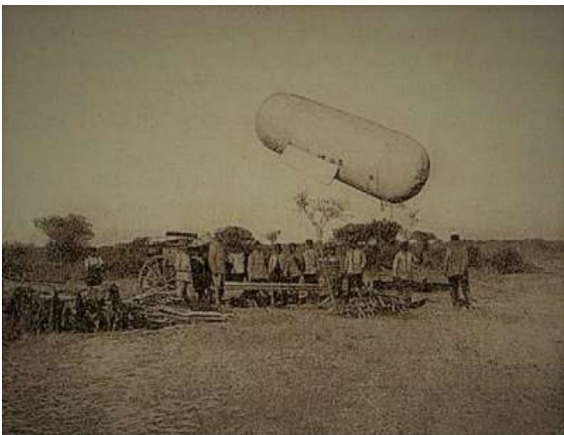
**Im Bild: Eine drahtlose Feldfunktelegraphenabteilung der deutschen Schutztruppe mit einem Ballon zum Aufziehen der Drahtantenne. 20**
